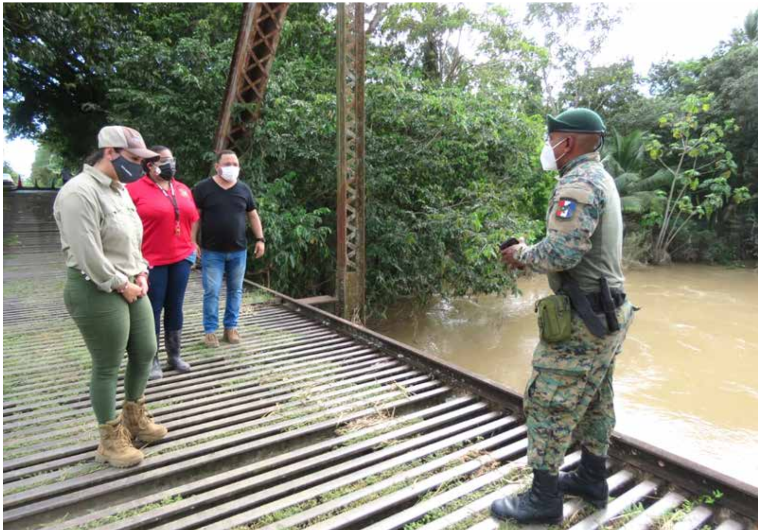
Cindy Monge, viceministra de Ambiente, coordinando una inspección sobre el puente del río Chiriquí Viejo, que comunica los distritos de Barú y Alanje.
