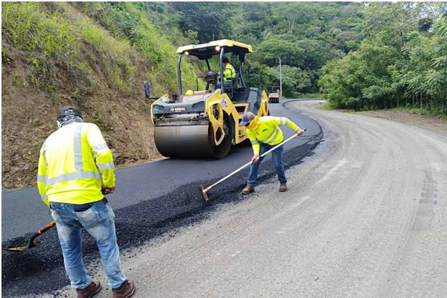
MOP avanza con la colocación de carpeta asfáltica en Loma La Saína, en la provincia de Los Santos.
